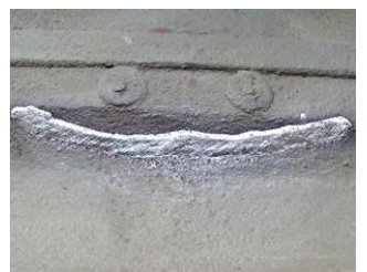
Riss komplett geschlossen
