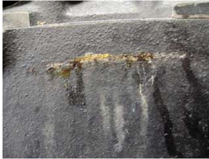
▲ Bild 4. Der mit bloßem Auge an Rost- und Kalkspuren erkennbare sichtbare Riss (links) wurde mit einem 3-mm-Fräser ausgearbeitet (rechts)
