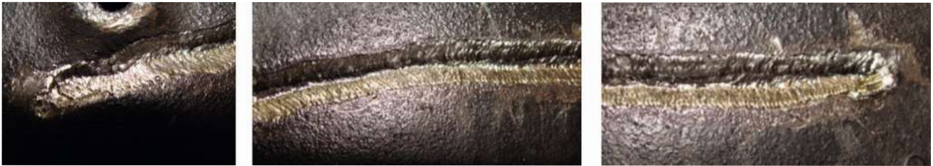
▲ Bild 10. Jede Lage wird von der Rissmitte nach außen abwechselnd in kurzen Abschnitten geschweißt.
