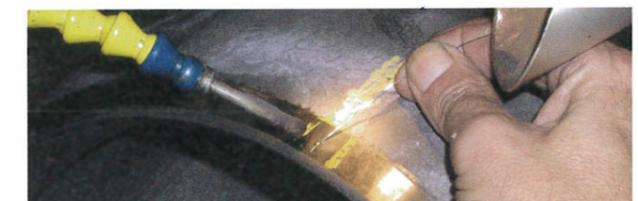
Abb. 36: Zonale Reparatur einer Stellite 6-Auftragung, Schweißgut NiCr22Co12Mo9 (2.4627)
