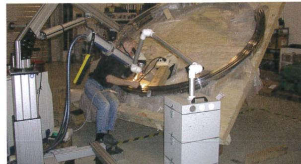
Abb. 18: Reparatur des Profilinges mittels Laserschweißung
