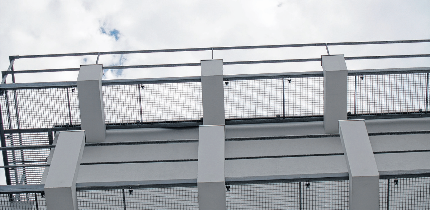
Der Mauerseglernachwuchs soll künftig an der Fassade des Mühlacker Krankenhauses eine gut eingerichtete Kinderstube vorfinden.
